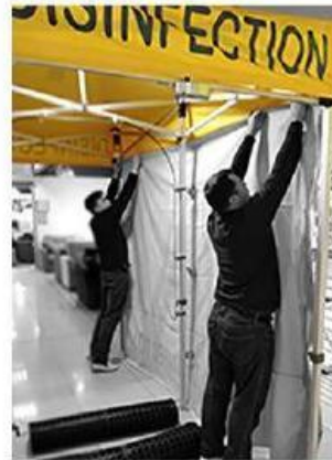
УСТАНОВКА СТЕН ТУННЕЛЯ
